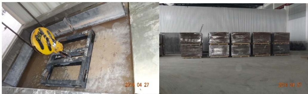
嘉华电厂催化剂再生照片
