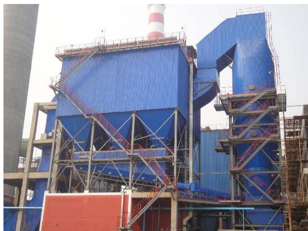
现场工程照片
